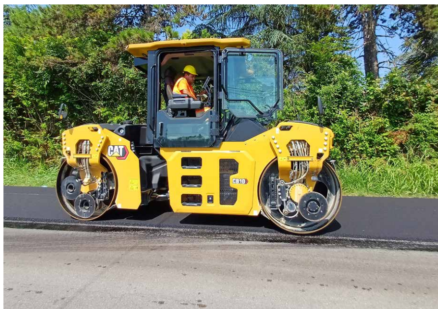
3. I nuovi rulli articolati Cat sono dotati di diverse tecnologie per aumentare la sicurezza, la produttività e l'efficienza del cantiere. La tecnologia Cat® è di facile utilizzo, versatile e modulare: è possibile scegliere l'equipaggiamento sulla macchina in base alle proprie esigenze, ora e in futuro
